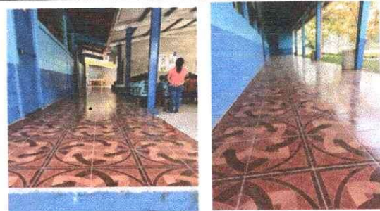
Foto 4: CAMBIO DE PISOS EN CORREDORES FINALIZADO
