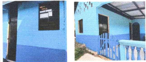
Foto 6: CAMBIO DE PUERTAS Y VENTANAS DE MADERA POR METAL FINALIZADO
