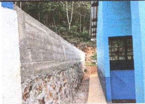
Foto 3: MURO DE CONTENCIÓN FINALIZADO
