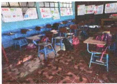
Foto 5: CAMBIO DE PISO EN AULAS FINALIZADA
